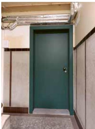
D'autres interventions ont également été réalisées comme le renforcement incendie des gaines techniques dans les communs, le changement des portes des locaux techniques de gaz et électricité.
