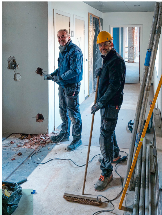
Luc et Anselmo sur le chantier des nouveaux bureaux de Comensia.
