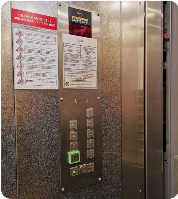
CHANTIER : HUNDERENVELD 1-2 ET 3-4 (BERCHEM)
