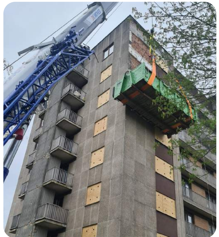
CHANTIER : PARC DU PETERBOS, 10-10A ET 11-11A (ANDERLECHT)
